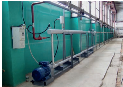
Общий вид рабочего стенда по выработке углерода из воды
